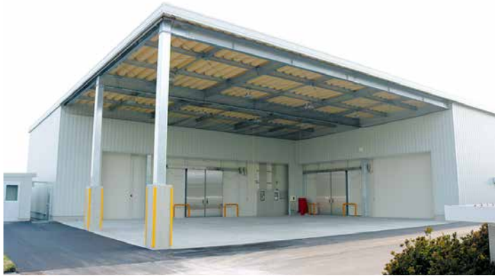
完成した甘藷貯蔵施設
