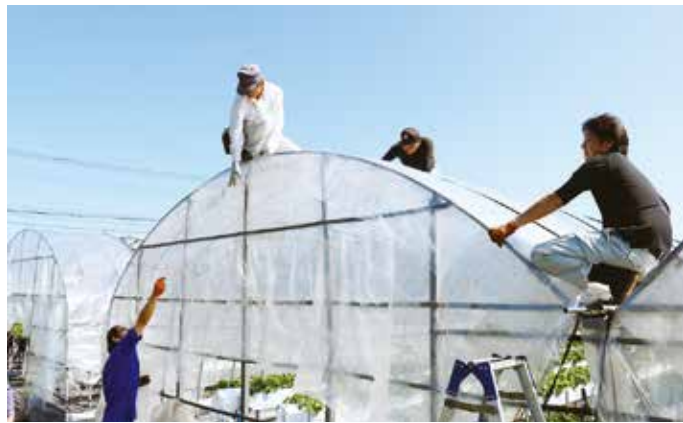
被覆作業をする職員ら
